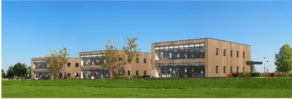
VUE SUR LA FACADE ARRIERE
